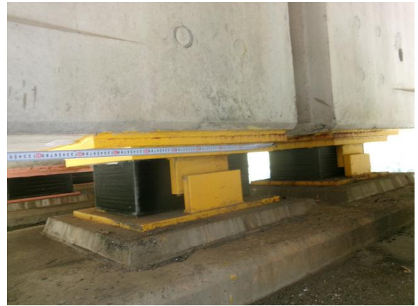
이동량 측정 작업전경
