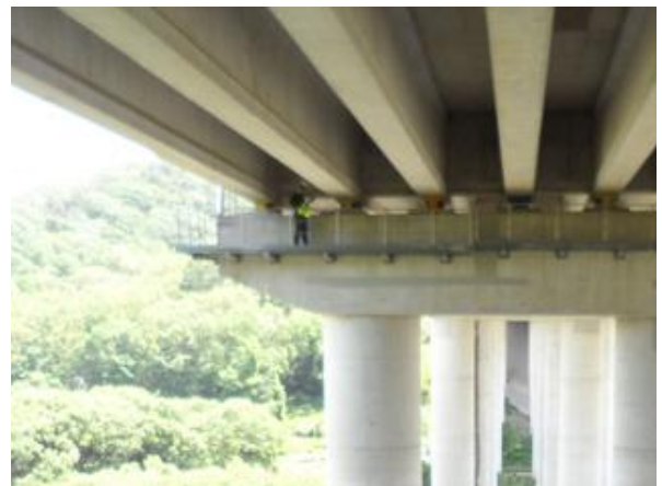
점검통로 도보 작업전경
